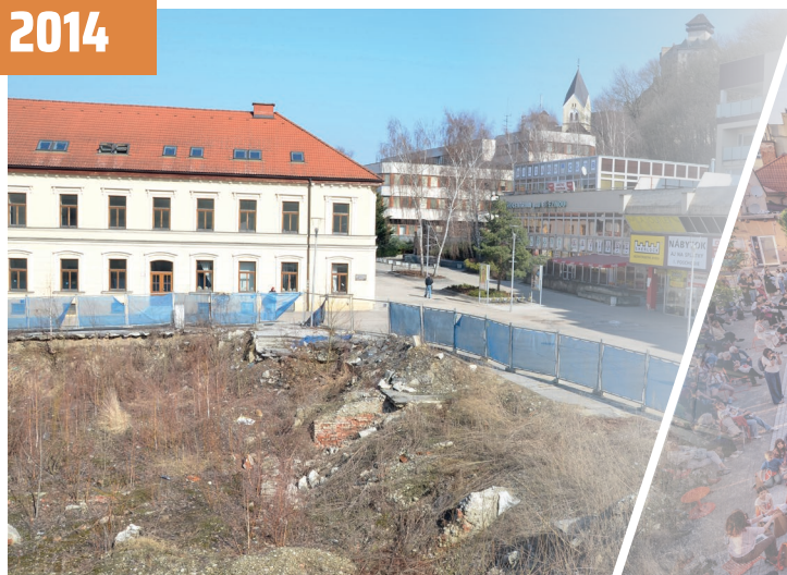
Jama pred Posádkovým domom, ktorá roky „špatila“ centrum mesta a bránila jeho rozvoj
